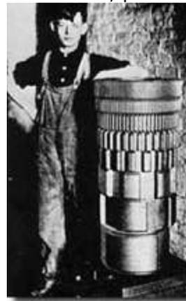
1897 por Tadheus Cahill, e só apresentado ao público em 1906. Ele utilizava 145 dínamos, rotores e bobinas especiais, que produziam diferentes freqüências de áudio, que podiam ser combinadas para enriquecer a composição harmônica dos timbres. Mas o exemplo mais clássico do uso de síntese aditiva é o órgão Hammond, fabricado nos EUA entre 1935 e 1974.
